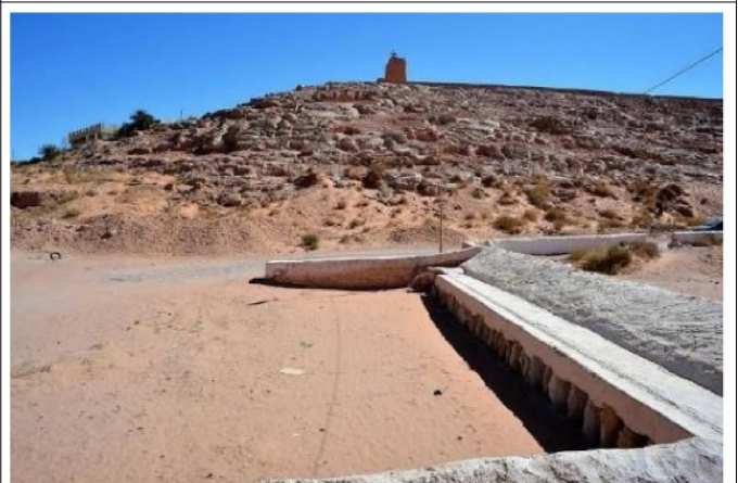
Différents retenues des eaux (Le M'zab: Regards d'urbanisme et de sociologie. De Brahim Benyoucef).
