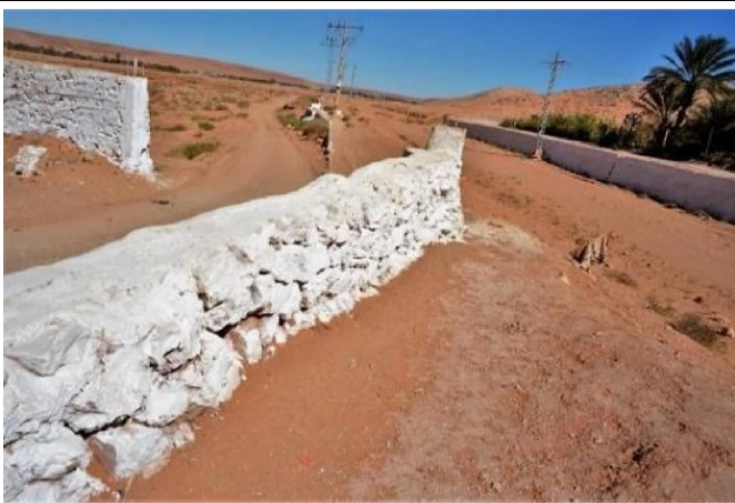
Muret de canalisation des eaux (Ghardaïa).
