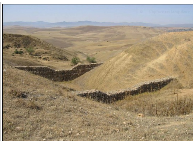
Seuil en pierres dans un ravin.
