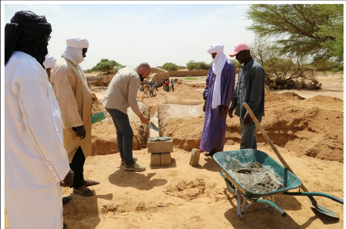
Réhabilitation du barrage d'Intikoi dans les environs de Kidal (Mali).
