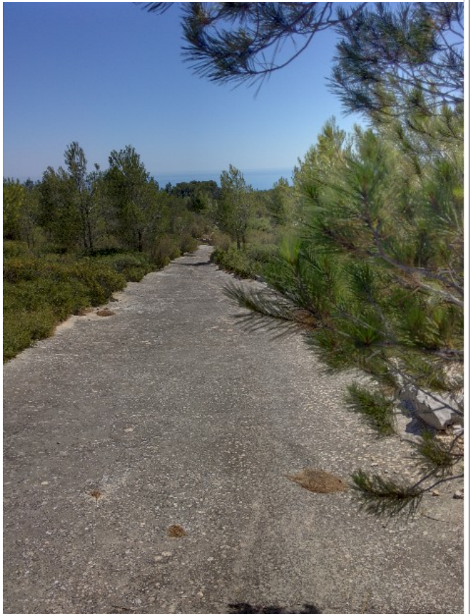
Impluvium en ciment alimentant une citerne enterrée d'une capacité de 50 000 litre (Bouches du Rhône France). Dimensions : 200 mètres x 7 m. ©BELAID.
