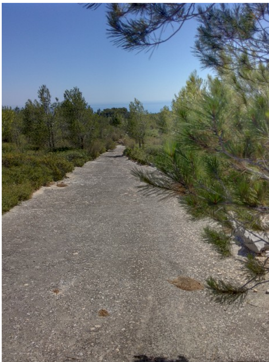
Impluvium cimenté permettant l'approvisionnement d'une citerne enterrée d'une capacité de 50 000 L d'eau (Bouches du Rhône). ©Belaid.
